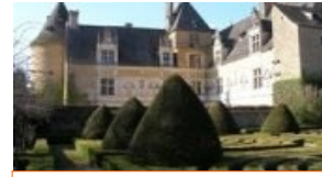
Château de Montal coté cour
