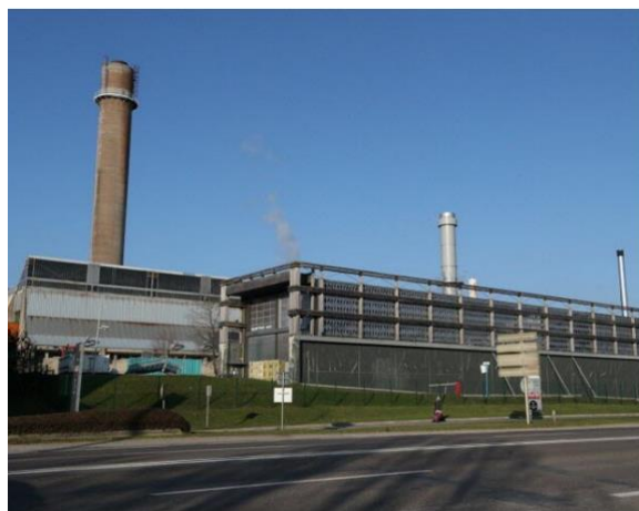
Besançon le 30/11/20 Chaufferie bois Planoise Photo ER /Arnaud CASTAGNE
